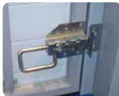
Cierre bilateral mediante cerrojos atornillados con alojamiento diseñado para apriete.
